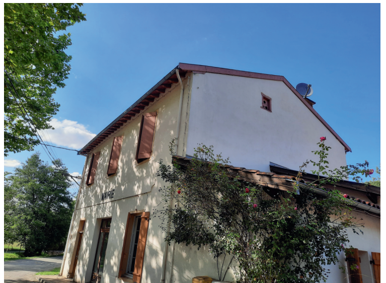
L'ensemble du bâtiment de la mairie sera concerné par la première tranche des travaux d'isolation
